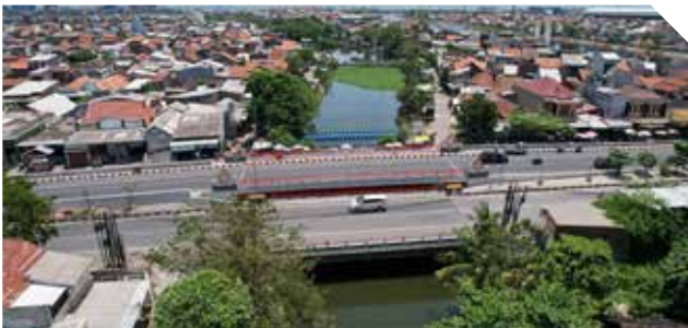
Jembatan Kalibanger, Semarang, Jawa Tengah | Central Java
