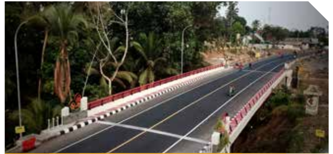
Jembatan Kalitakir, Banyuwangi, Jawa Timur | East Java
