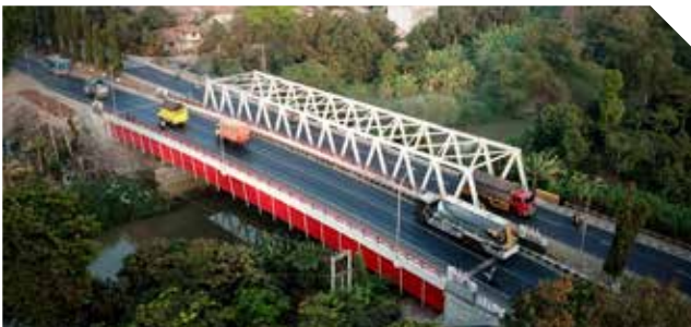
Jembatan Ciasem, Subang, Jawa Barat | West Java
