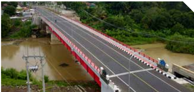
Jembatan Cimanuk, Sumedang, Jawa Barat | West Java
