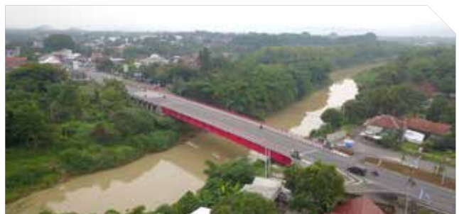
Jembatan Cilutung, Perbatasan Sumedang-Majalengka, Jawa Barat | West Java
