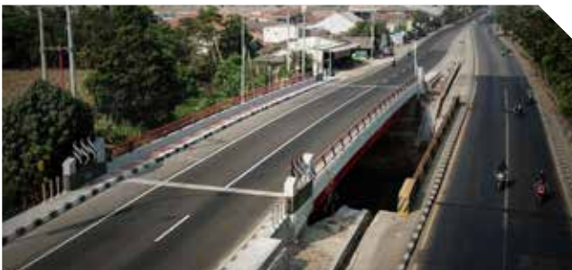
Jembatan Cipangaritan, Pamanukan, Jawa Barat | West Java
